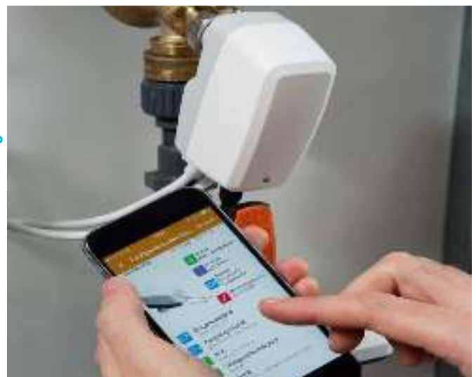
Fig. 14. Programmazione delle portate di riscaldamento e di raffrescamento usando l'attuatore della valvola di regolazione indipendente dalla pressione
