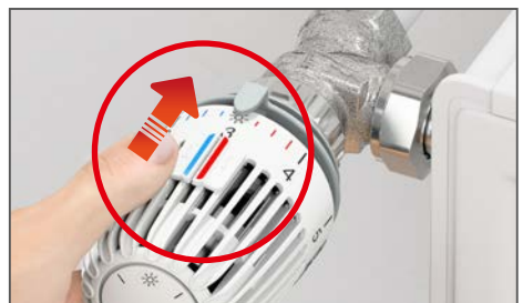
Abb. 11: Sparclip nach vorn schieben
