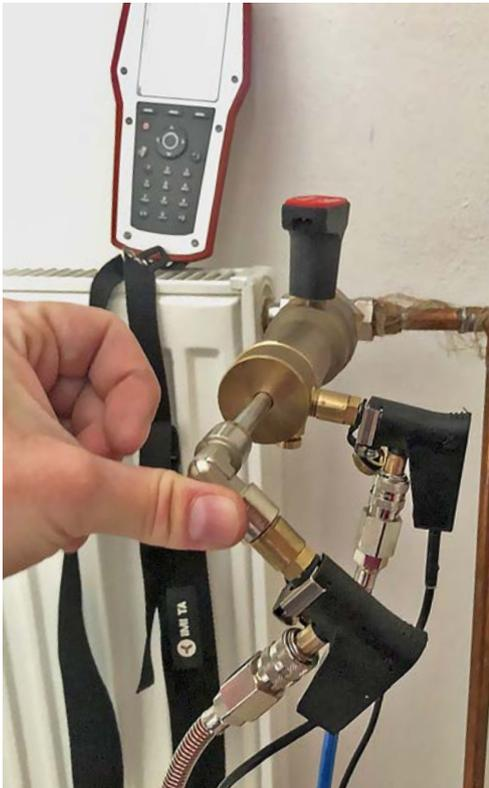
Bei der Inbetriebnahme werden die Differenzdrücke an den Radiatoren stichprobenartig kontrolliert. Dadurch wird eine ordentlichen Funktion der Eclipse Thermostatventile gewährleistet.
