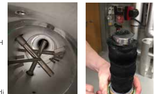
Vista interna della versione più grande di Ferro-Cleaner. Esempio di efficienza di Ferro-Cleaner
